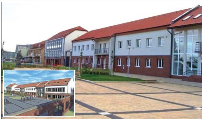
Polgármesteri Hivatal felújítása, Gazdasági Szolgáltatóház kialakítás
