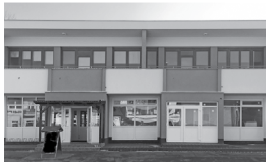
Munkácsy utcai 2 felújított önkormányzati lakás
