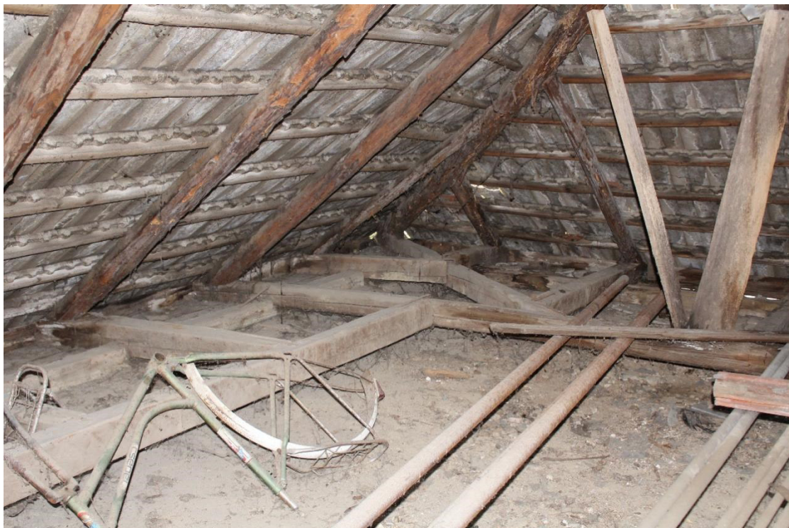
5. ábra – fiókváltós-kötőgerendás fedélszék
