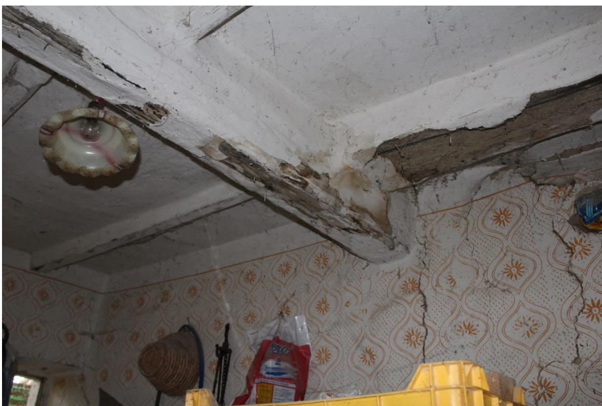
9. ábra – vékony födémgerendák, kiváltás, feltehetően tüzelőberendezés részére
