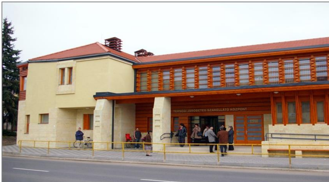
PÉTEGISZ Járóbeteg szakellátó épülete
