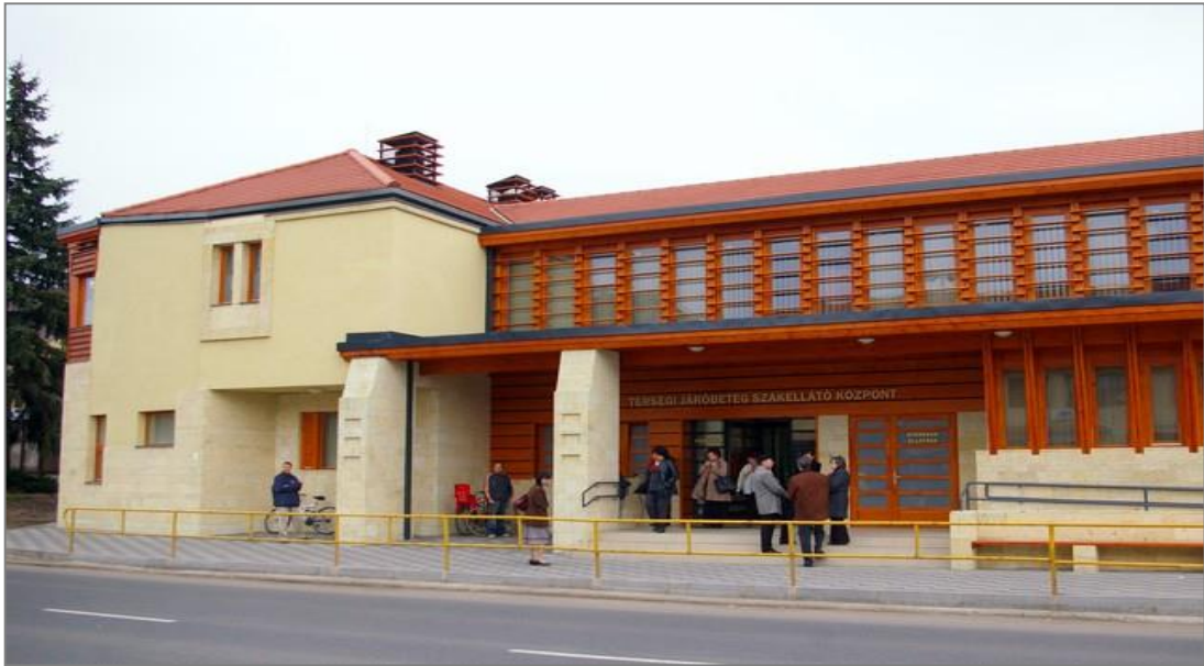
PÉTEGISZ Járóbeteg szakellátó épülete
