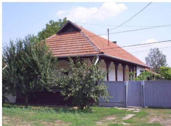
Bacsó u. 11. „Lakóház”
