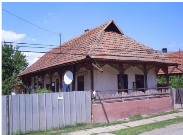
Kárpát u. 26. „Lakóház”
