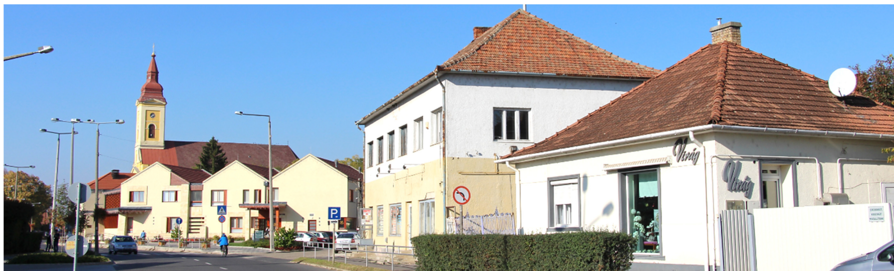
A városközpontból déli irányban kivezető Kodály Z. utat kísérő fsz+1 emeletes zárt sorú- házagosan zárt sorú, majd földszintes beépítés.
